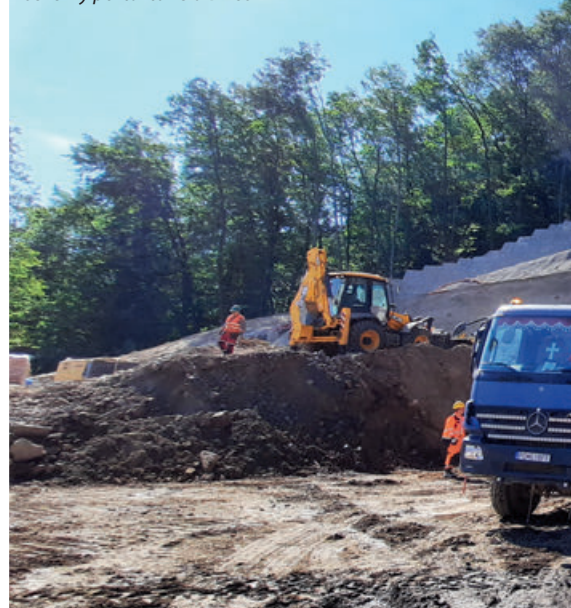
R4 – Severný obchvat Prešova, severný portál tunela Bikoš
