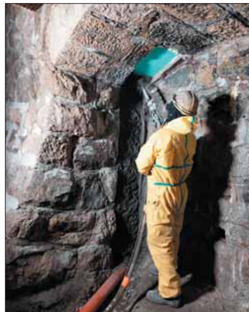
Obr. 9 Aplikácia striekaného betónu na zhotovené zvodnice
