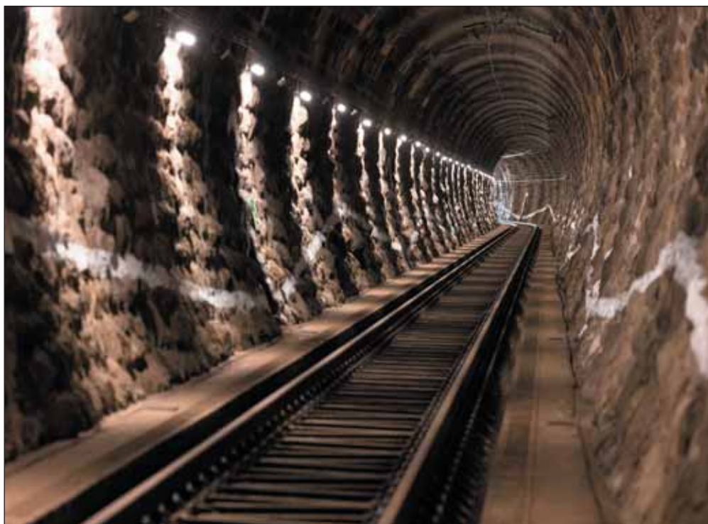
Obr. 10 Bratislavský tunel č. 2 po ukončených rekonštrukčných prácach
